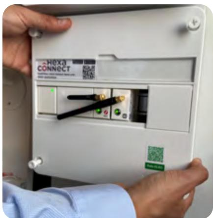
J'identifie l'emplacement de ma passerelle HEXACONNECT : sur le tableau électrique ou dans le coffret de communication de mon logement.
